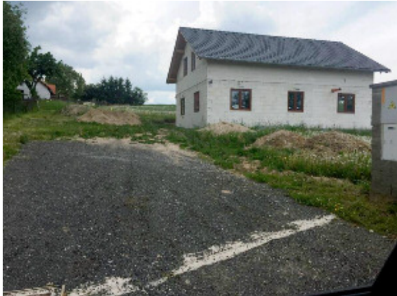
Pozov PZ01 (pohled of severu)
